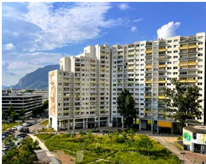
Quartier de la villeneuve - diagnostic Grenoble
