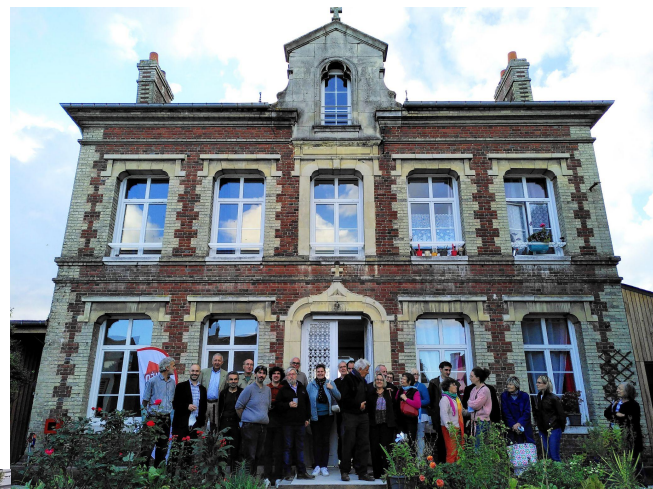
Le Presbytère - 2021 Quillebeuf-sur-Seine 5 logements Locatif Social Néologis / SNL
