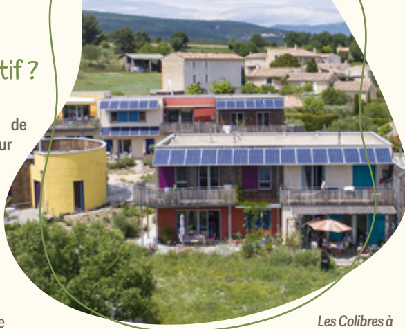
Les Colibres à Forcalquier (04) est un habitat participatif intergénérationnel construit suite à un appel à projet de la commune. Depuis 2017, 11 foyers, dont 4 logements pour les seniors et 1 pour un aidant, habitent dans le projet.
