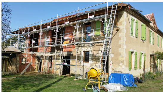
Façades sud et est, en travaux, 2021
